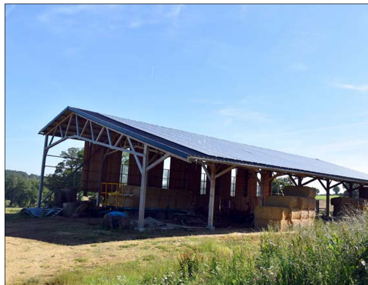
Le dernier projet avec toiture photovoltaïque. (Ph. S. D.)
