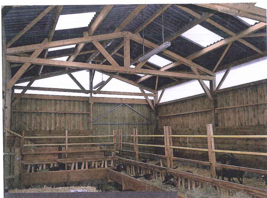
▲ LES TRANSLUCIDES SUR LE HAUT DU PIGNON, sur les longs pans et en toiture apportent une bonne luminosité à l'intérieur.
